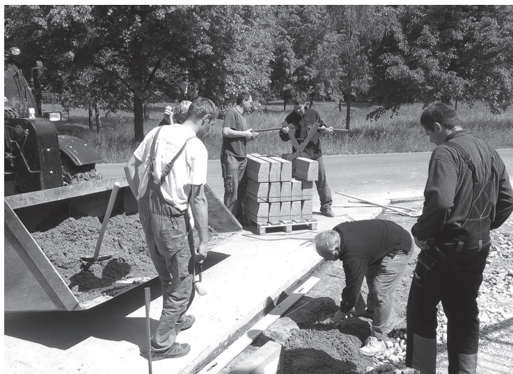
▲ Pokládka zámkové dlažby (Foto: R. Kašpar)
