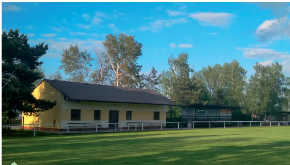
Opuštěný sportovní areál (Foto: T. Rejl)
